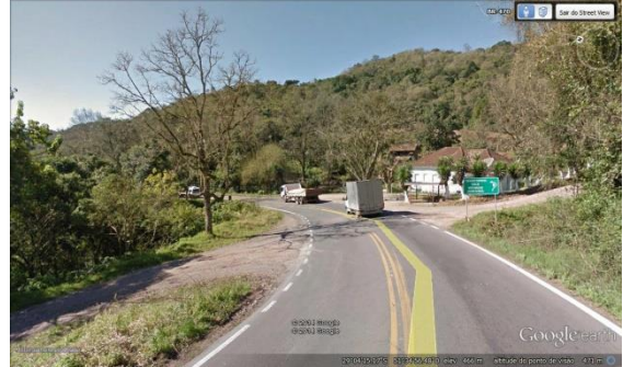
Figura 14: Estrada de acesso ao KM2. Fonte: Google Earth.
