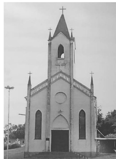
Figura 5: Atual Capela de Nossa Senhora da Glória - 1937
