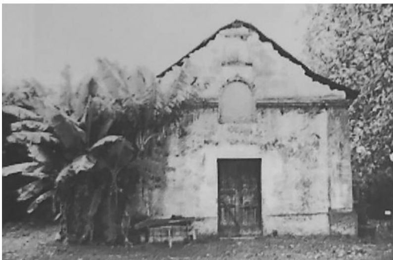
Figura 4: Antiga Capela de Nossa Senhora da Glória – 1894
