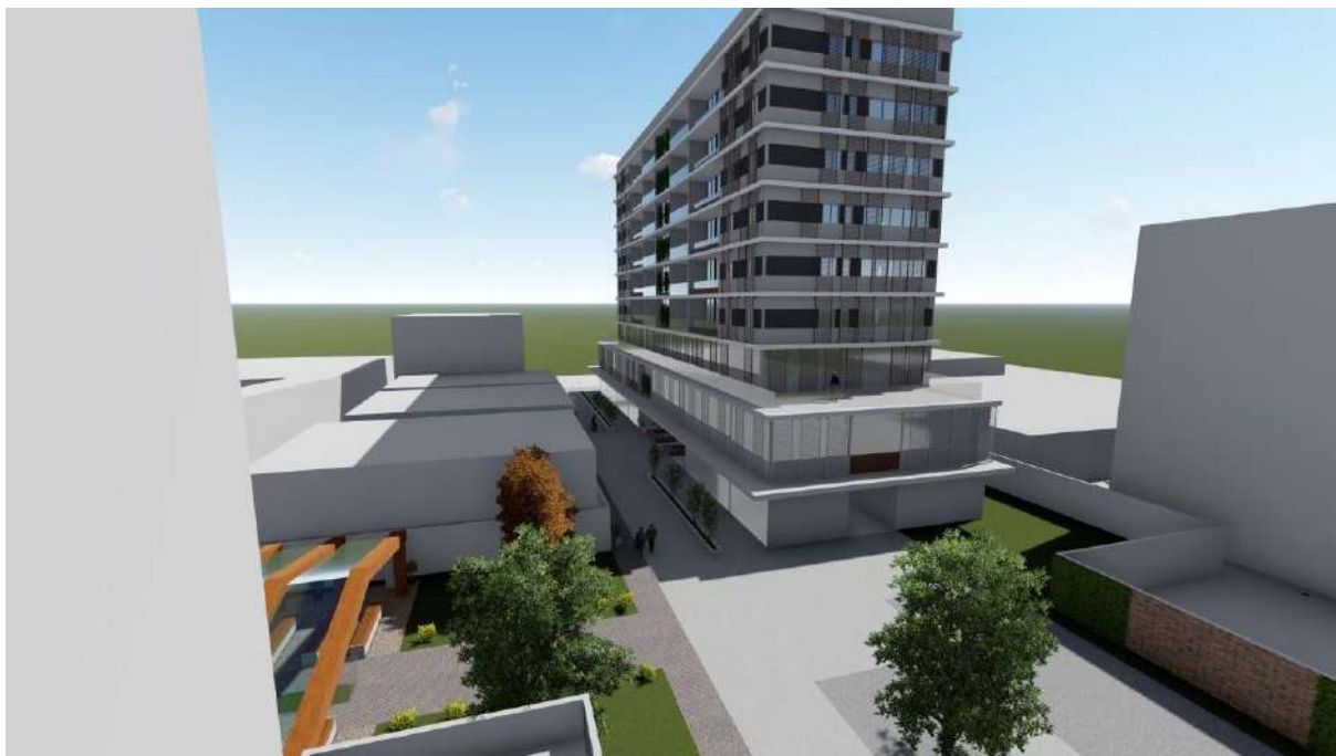
Figura 40 – Imagem aérea mostrando toda edificação
