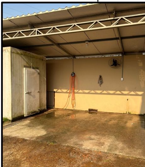
Figura 7 – Estrutura externa do Hospital de Clínicas Veterinárias. Área de higienização dos cavalos e ala de necropsia com câmara fria no local.
