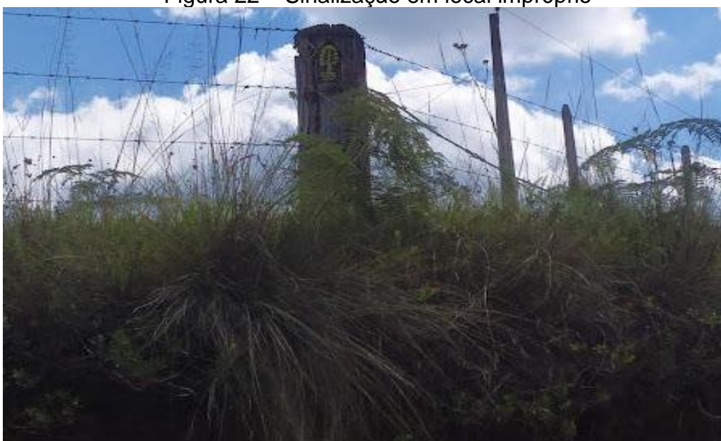
Figura 22 – Sinalização em local impróprio
