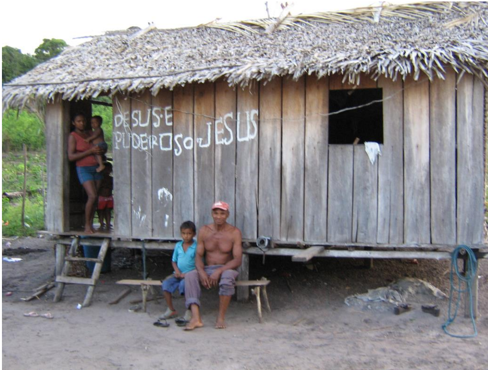
Figura 5: Imagem de perfil de uma casa na Comunidade de Banguelas, construída em madeira com cobertura de palha, destacando aspectos arquitetônicos locais
