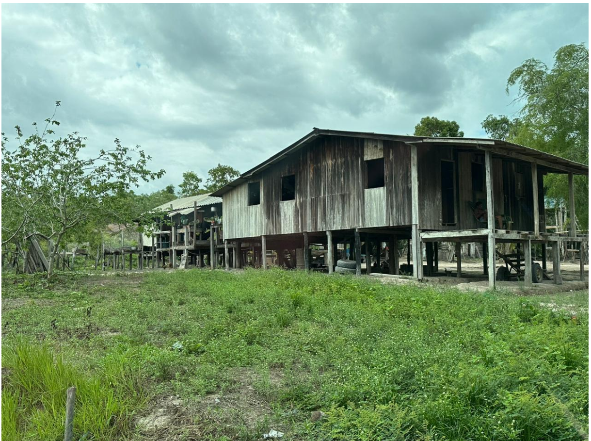
Figura 3: Residências de madeira elevadas, típicas da Comunidade de Banguelas, adaptadas às condições locais
