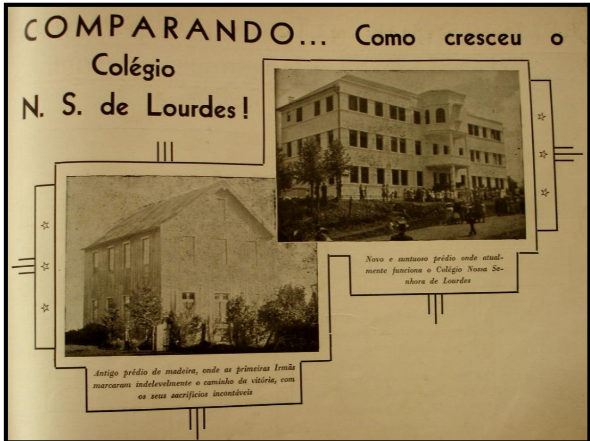
Figura 5: Colégio Nossa Senhora de Lourdes, prédio antigo e novo
