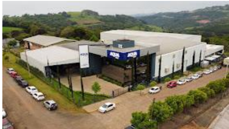
Figura 1 - Fachada da empresa
