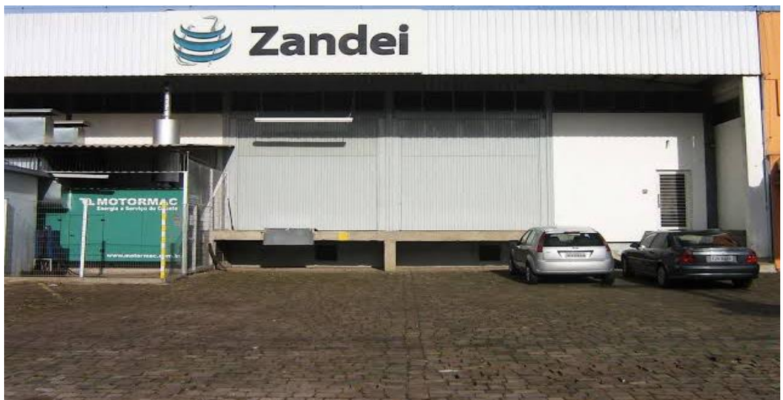
Figura 4 - Fachada da empresa
