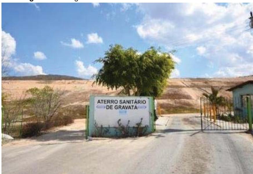
Figura 10: Imagem da entrada do aterro sanitário de Gravatá.
