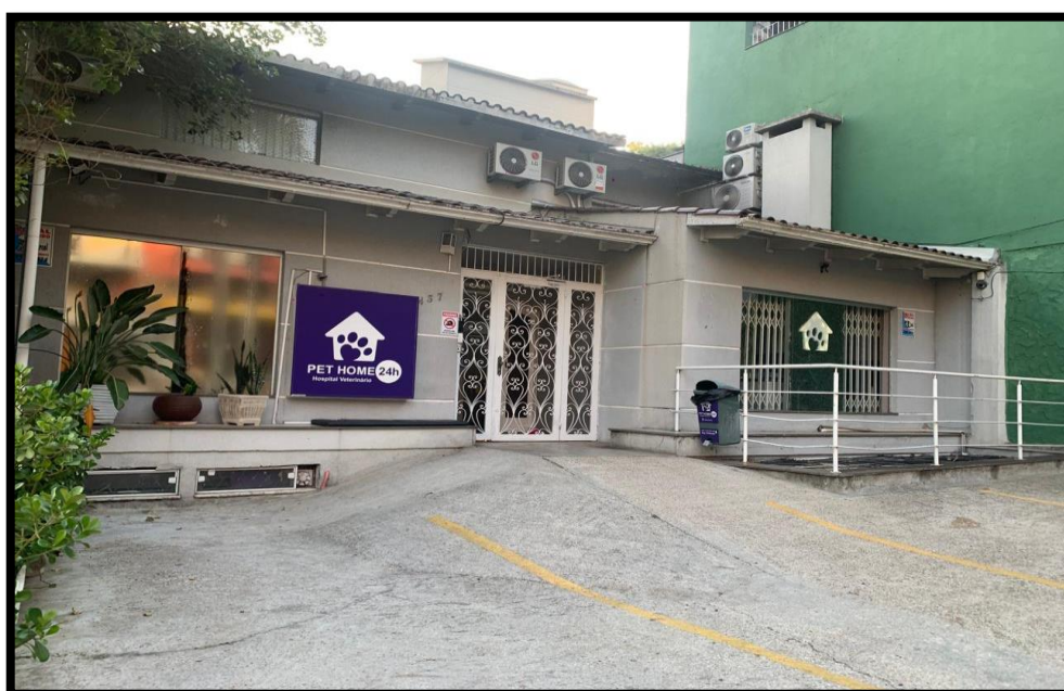
Figura 1 – Fachada do Hospital Veterinário Pet Home em Porto Alegre – RS
