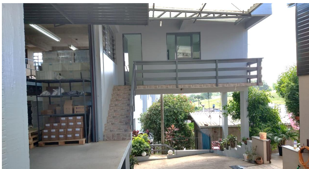
Figura 6 – Portão de acesso à edificação e acesso ao setor administrativo
