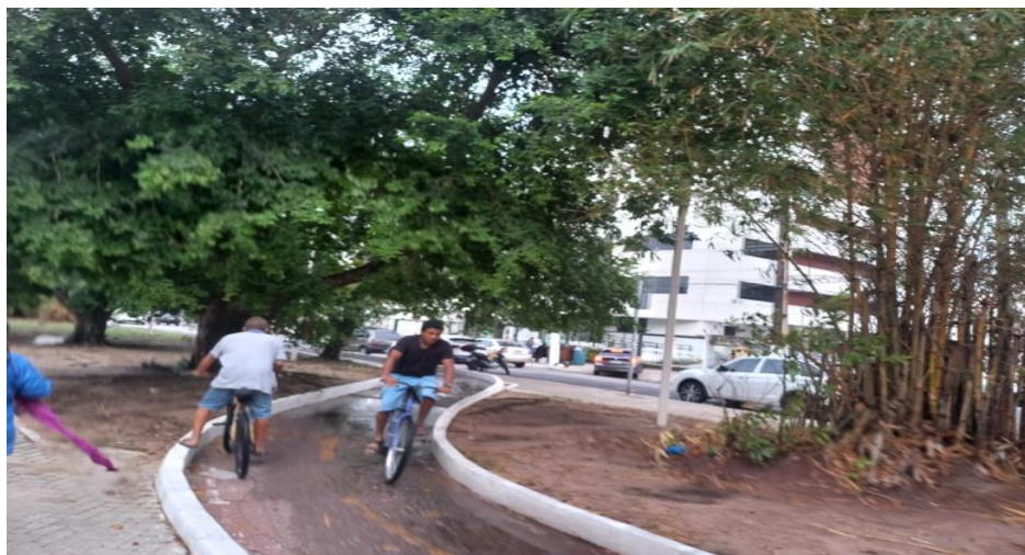
Fotografia- 17 Ciclovia da Avenida Marquês de Herval
