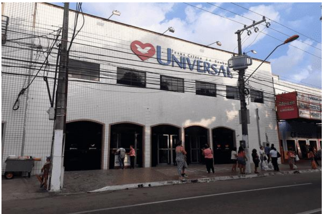
Fotografia-6 O Cine Paraíso hoje reformado e transformado em um templo
