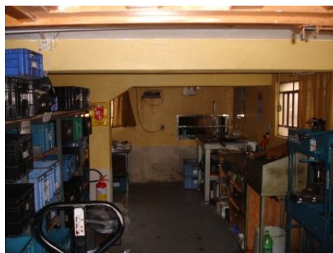
Vista interna do Prédio
