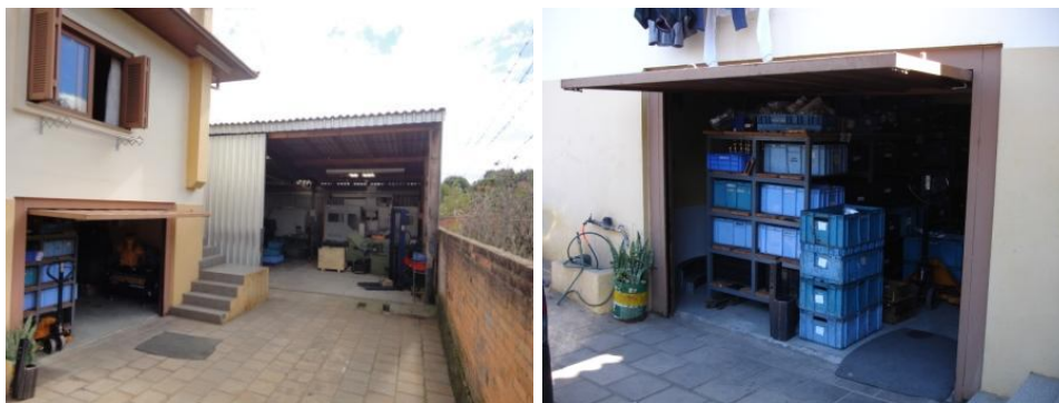
Vistas externas do Prédio
