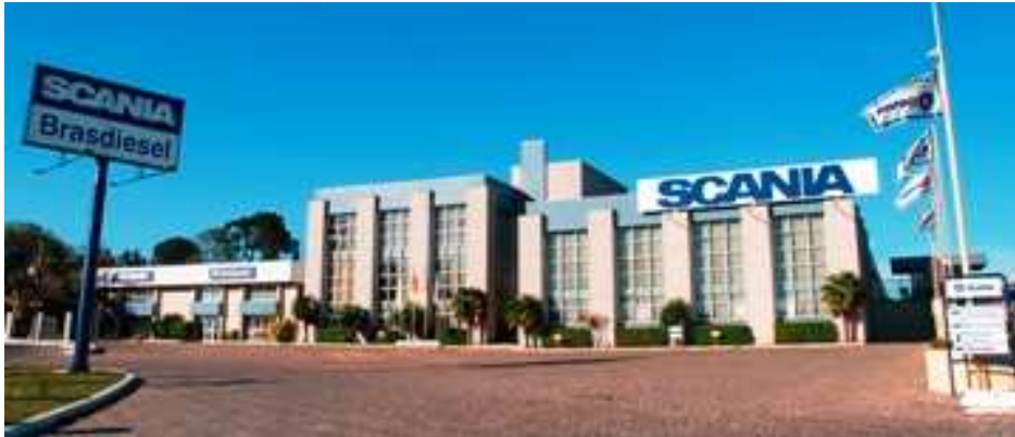
Figura 5: Prédio da Brasdiesel em Caxias do Sul
