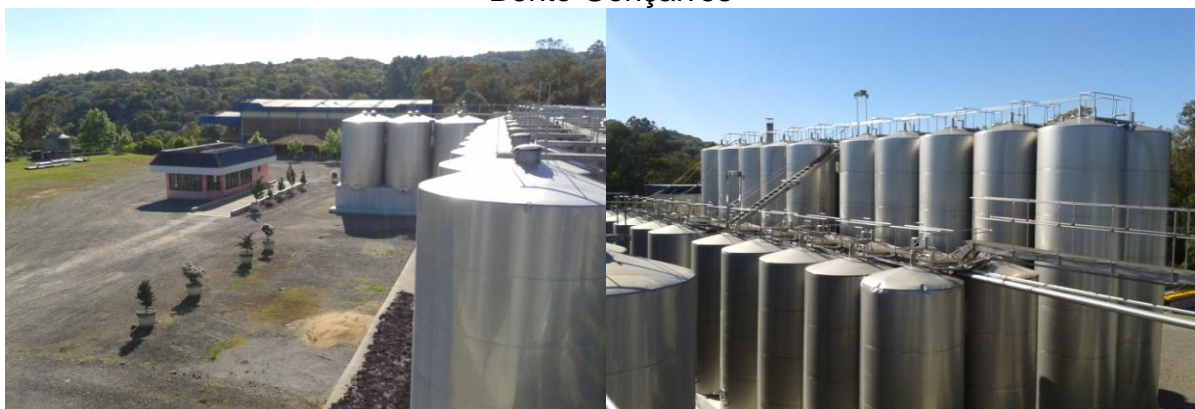
Figura 2 - Vista do pátio externo, tanques de inox para vinhos e sucos, na filial de Bento Gonçalves
