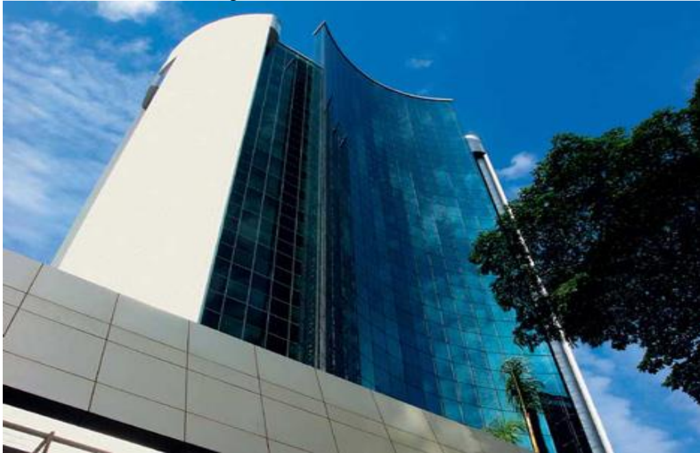
Figura 14 – Fachada de vidro
