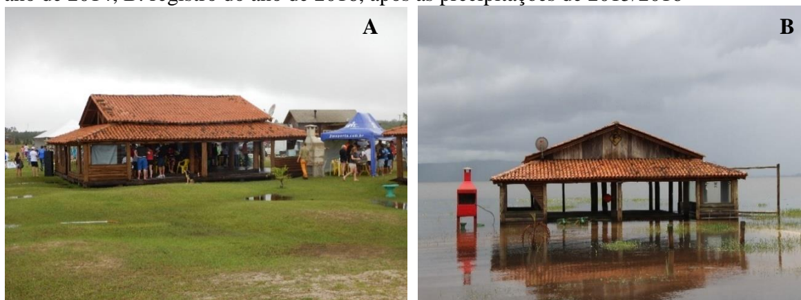
Figura 11: Instalações do empreendimento Rajada Turismo de Aventura - A: registro realizado no ano de 2014; B: registro do ano de 2016, após as precipitações de 2015/2016
