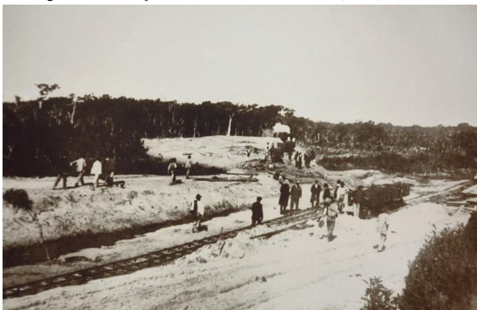
Figura 6: Escavação Canal Marcelino-Peixoto (1916)
