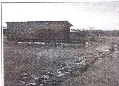
F9: Extensa rede de drenagem.
