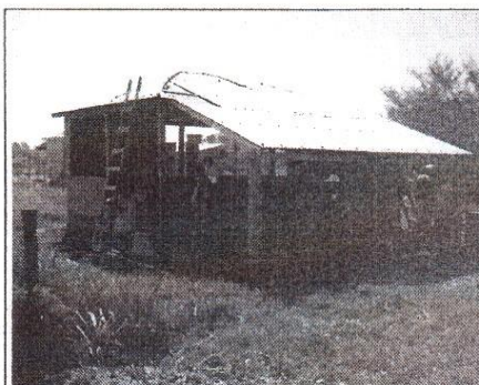
F13: Construção nova ainda em obras.
