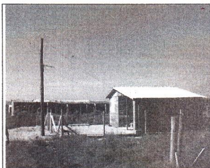
F15: Construção nova recém concluída.
