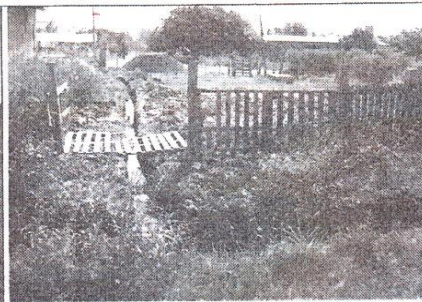
F10: Drenagem até entre os lotes, indicativo de alto nível do lençol freático, provável área alagável.
