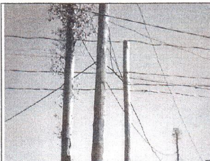
F19: Ligações clandestinas de eletricidade.
