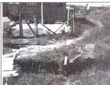
F21: Lançamento de esgoto sanitário na sarjeta.
