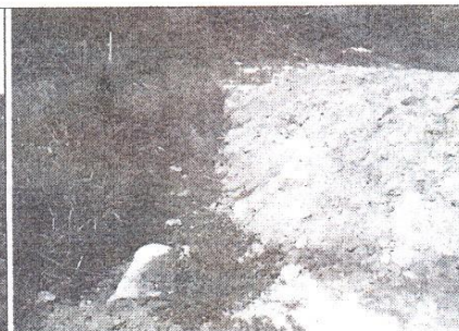
F12: Via sendo aterrada.
