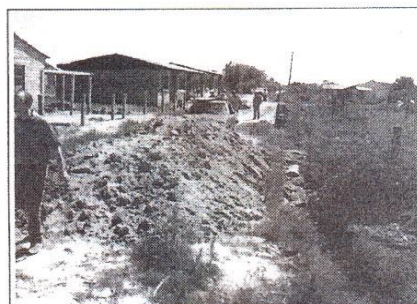
F11: Aterro novo em andamento.
