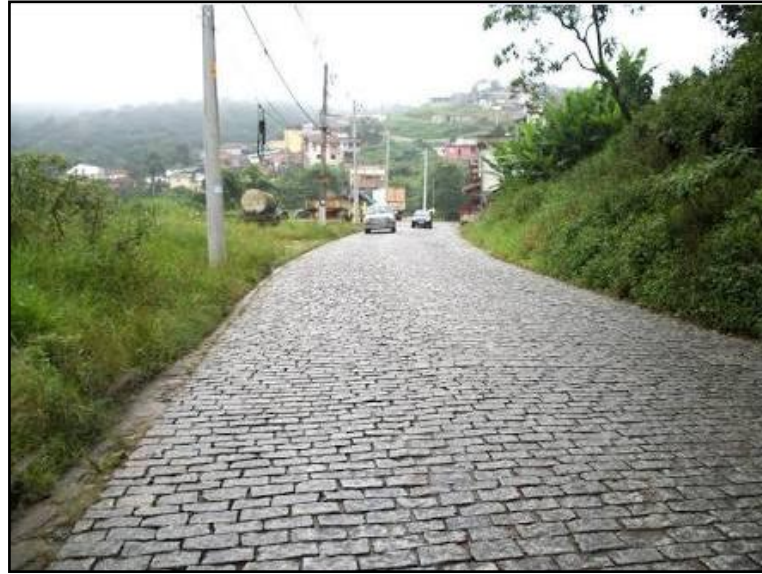
Figura 19 - Pavimentação com paralelepípedos
