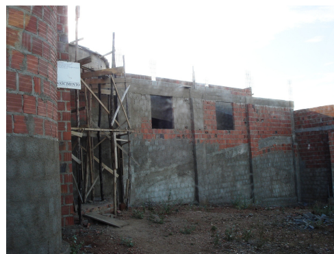
Figura 20: Construção da primeira Enoteca Pública do mundo Fonte: Acervo da autora.
