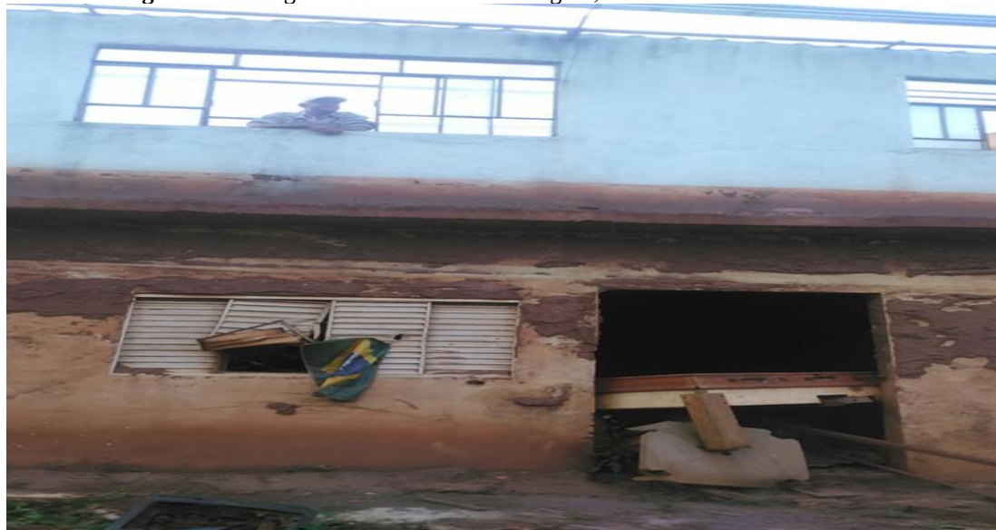
Figura 10 - Antigo morador de Bento Rodrigues, visitando a sua casa destruída
