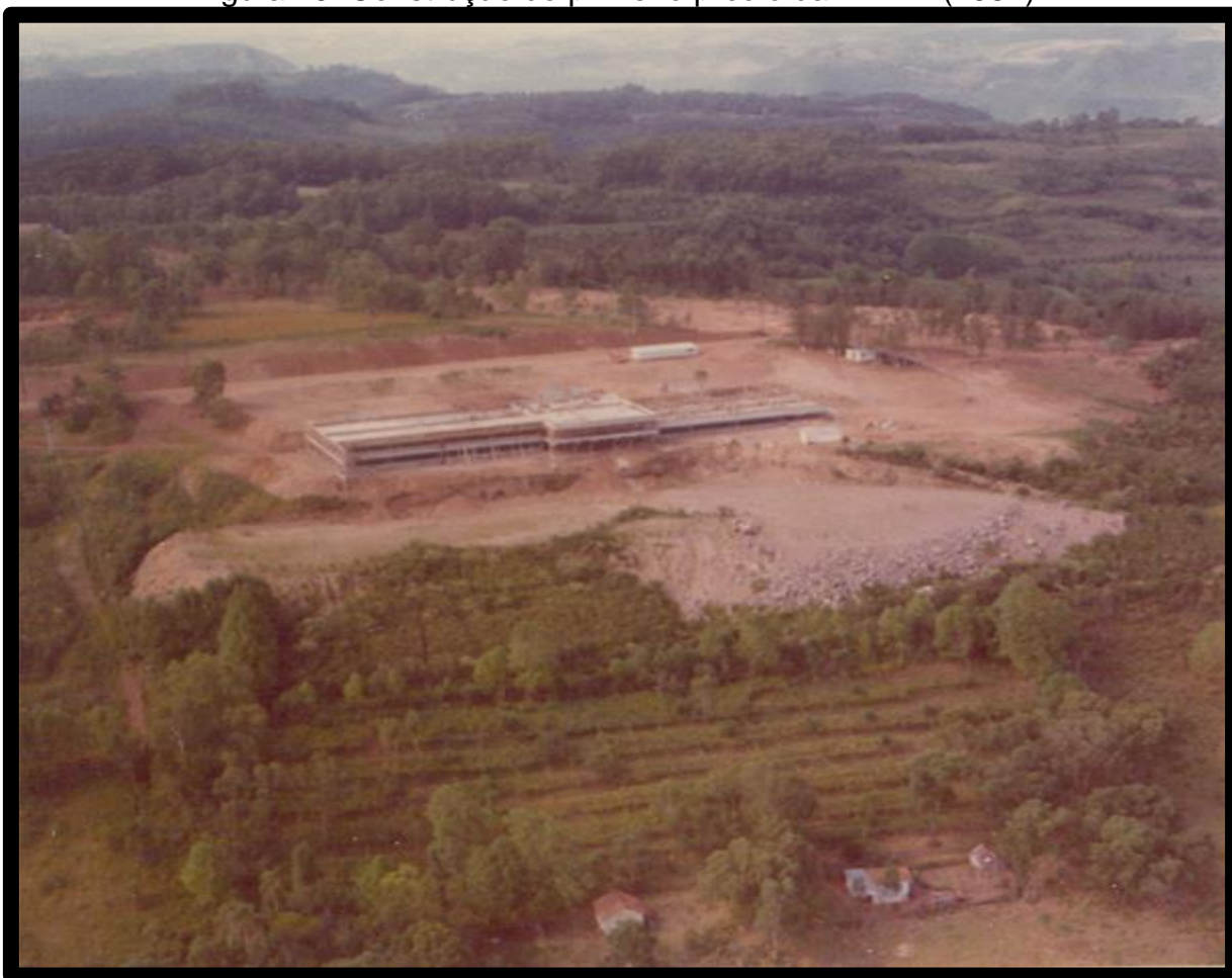
Figura 29: Construção do primeiro prédio da FERVI (1982)
