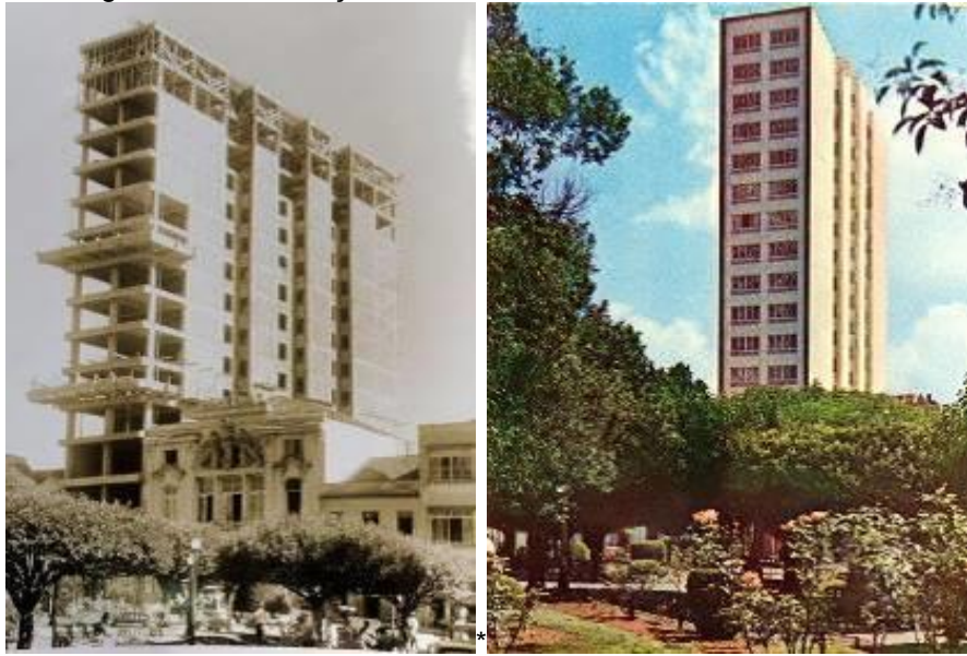
Figura 54 – Construção e o edifício “caixa de fósforo” finalizado.
