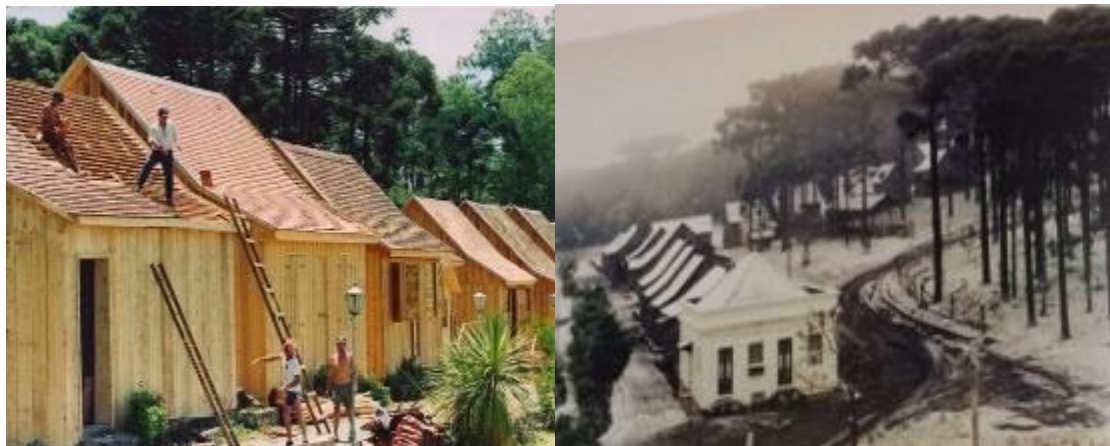
Figura 69 – Construção das Réplicas Caxias-1885 (sem data), e as construções prontas no inverno de 1978.
