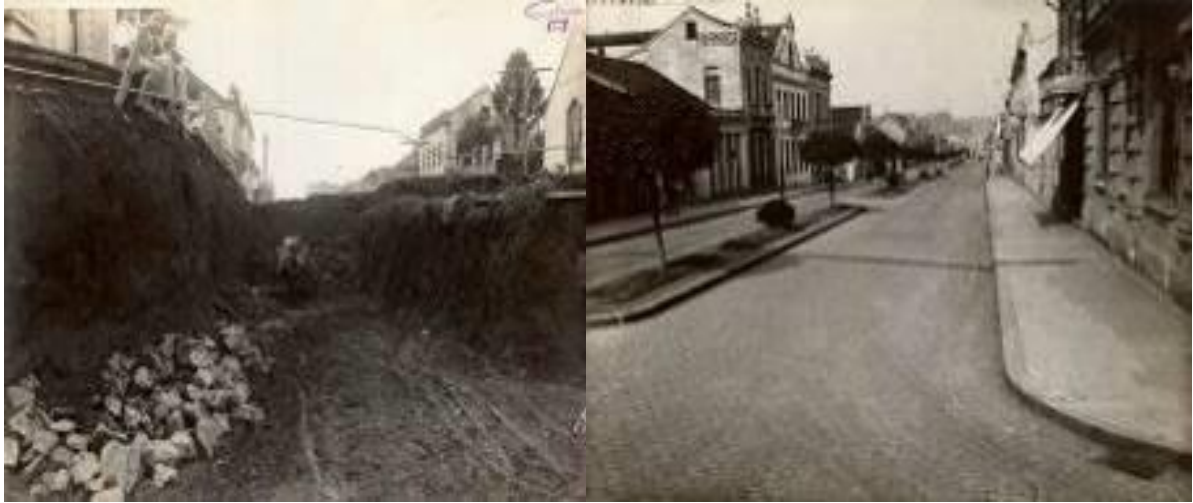
Figura 38 – Obras de saneamento e pavimentação durante a década de 1940 na Avenida Júlio de Castilhos.
