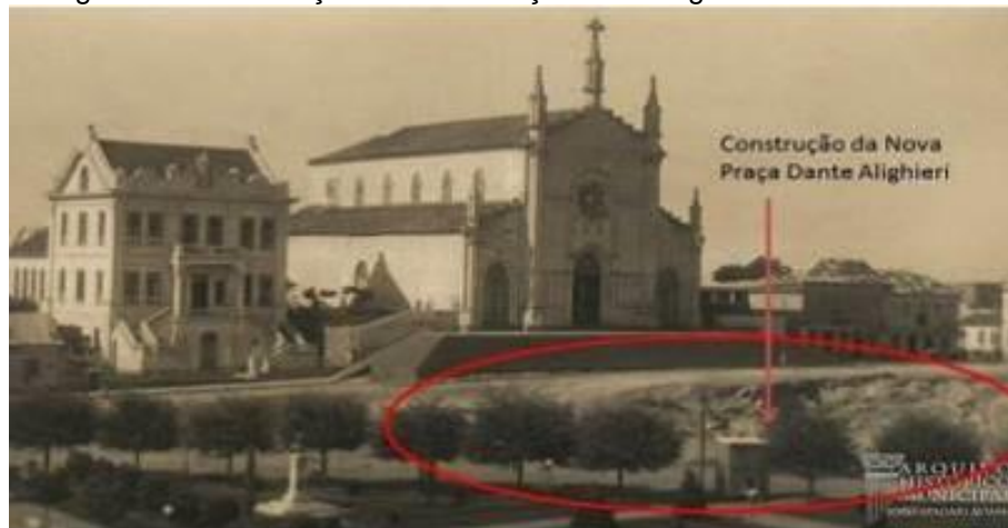
Figura 30 – Construção da nova Praça Dante Alighieri entre 1924-1928
