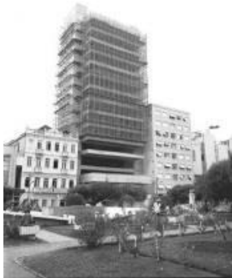
Figura 64 – Edifício do Banco do Brasil (1971-1974)
