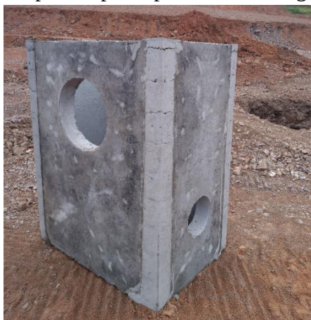
(c) Caixa coletora sem tampa com detalhe de furações
