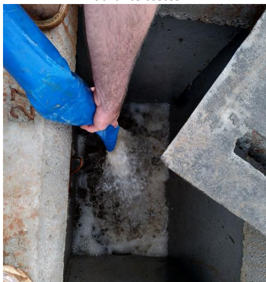
(f) Vazão sendo aplicada na boca-de-lobo
