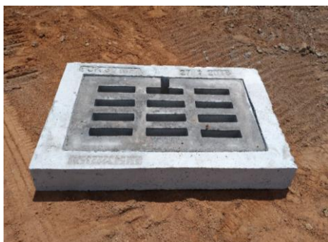
(a) Tampa composta por colarinho e grelha
