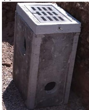
(d) Caixa coletora já posicionada sobre camada de brita e com tampa em grelha
