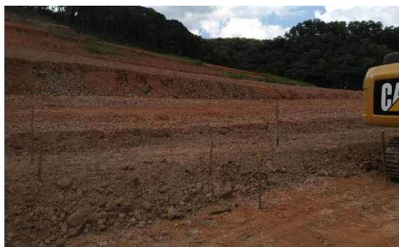
(a) Estaqueamento Poço 1
