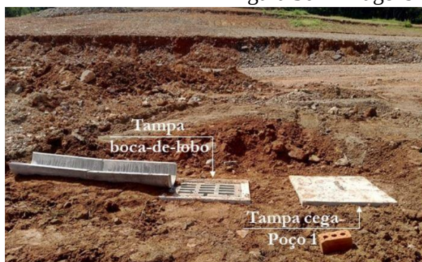
Figura 30 – Imagens dos poços após reaterro
