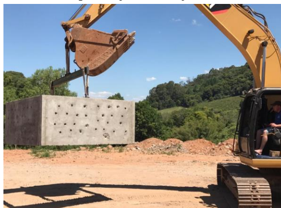
(b) Paredes sendo transportadas até a vala
