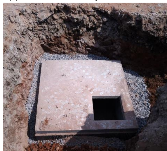
(d) Paredes, tampa e lateral de brita já instaladas
