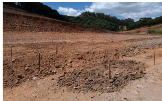
(b) Estaqueamento Poço 2
