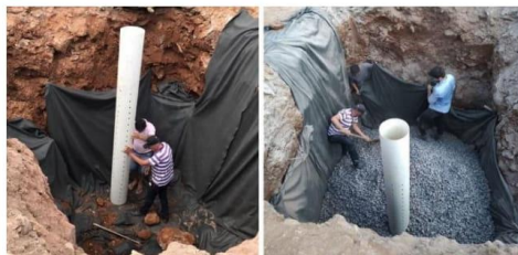
Figura 5 – Fotos do processo de implantação do Poço 2
