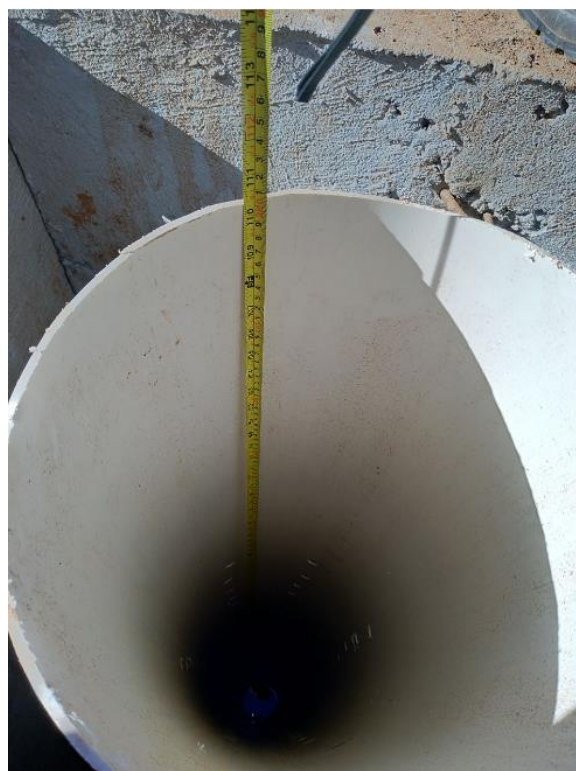
(b) Visão da chaminé do Poço 2
