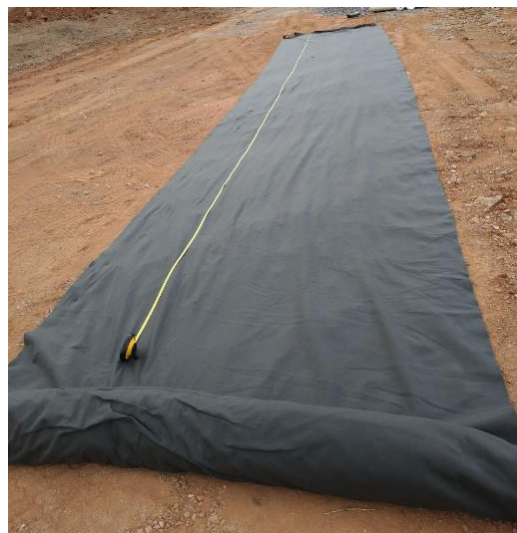
(b) Corte da manta geotêxtil
