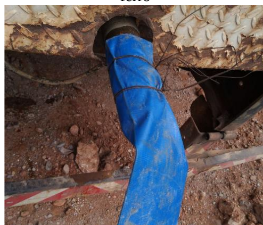
(d) Mangueira acoplada ao tubo de ferro durante testes
