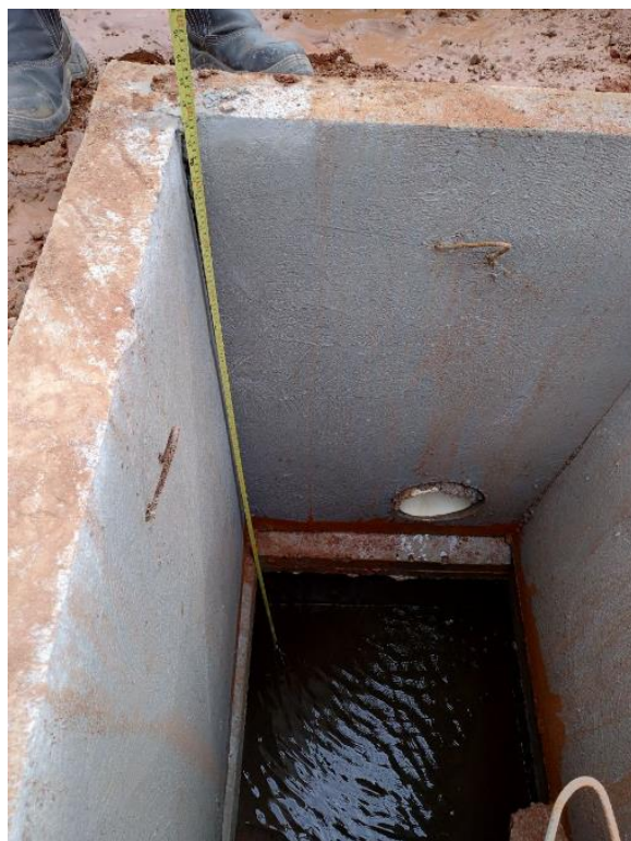
(a) Visão da chaminé do Poço 1
