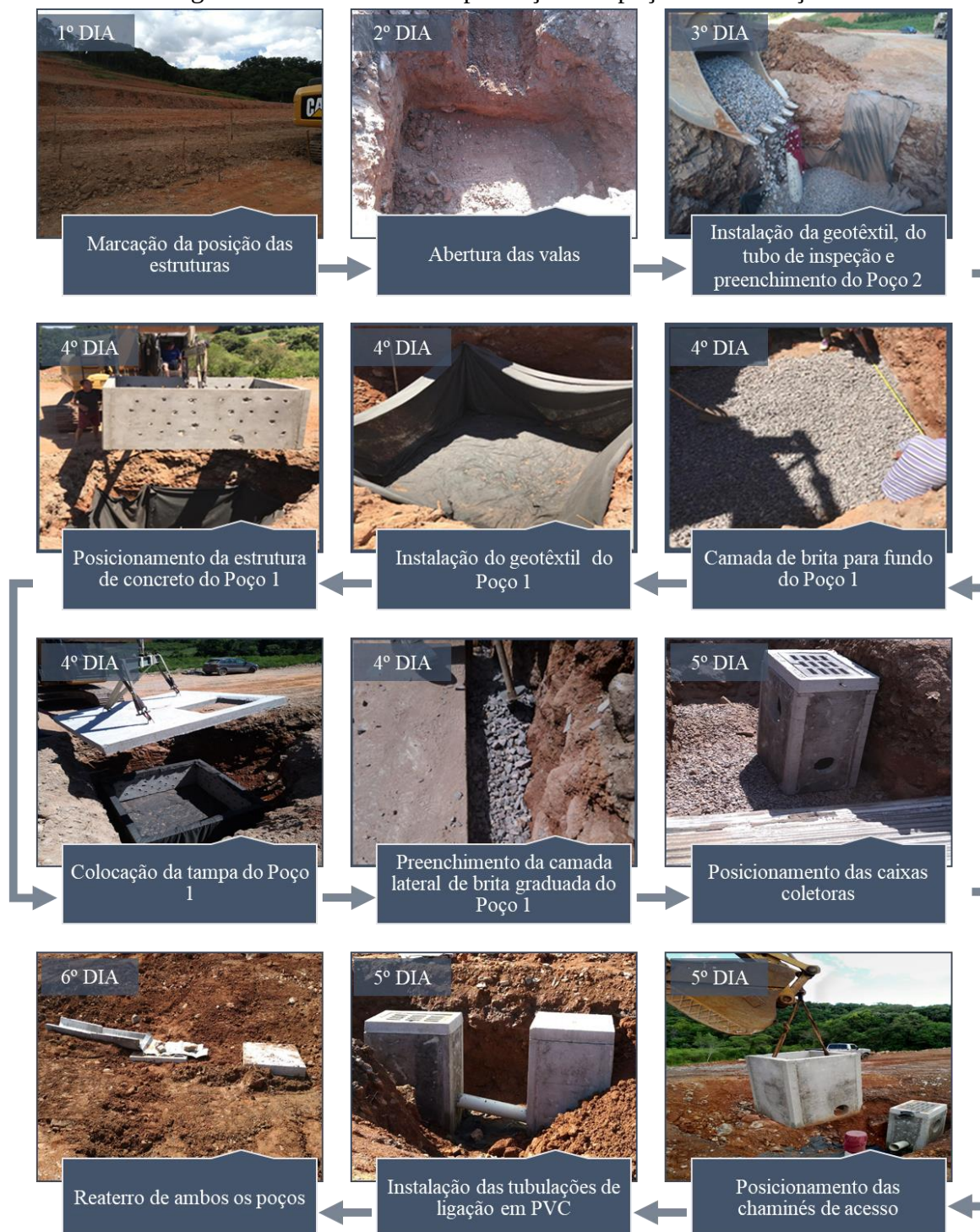
Figura 28 – Processo de implantação dos poços de infiltração
