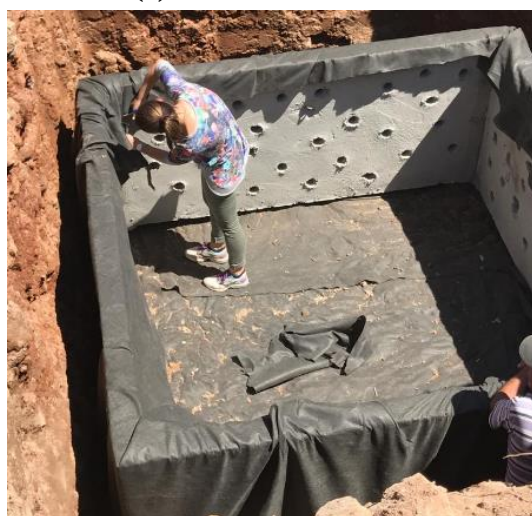
(c) Geotêxtil sendo instalada nas laterais
