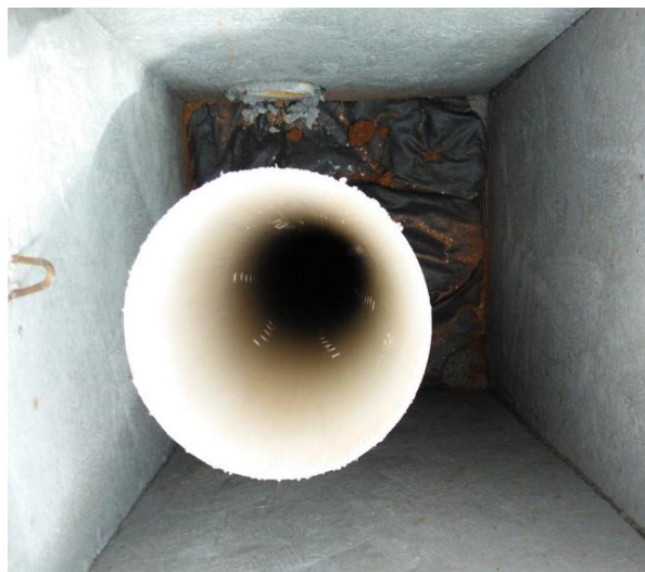
(a) Vista do interior do tubo de PVC já instalado no Poço 2
