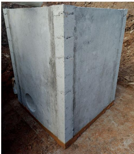
(a) Chaminé de acesso posicionada sobre tampa do Poço 1
