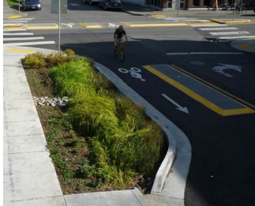
Figura 4 – Jardim de chuva na cidade de Portland - EUA
