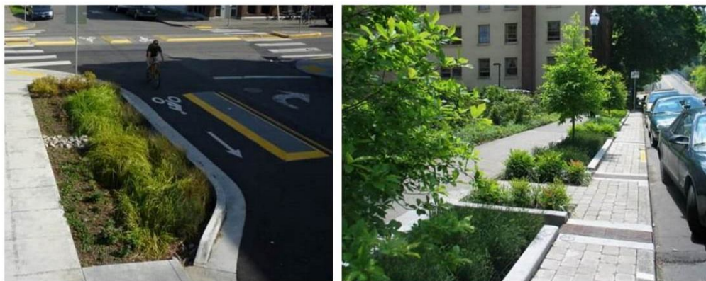
Figura 2 – Jardim de chuva e canteiro pluvial em Portland, EUA
