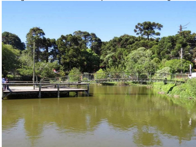
Figura 24 – Estrutura metálica para acesso à ilha do lago sul
