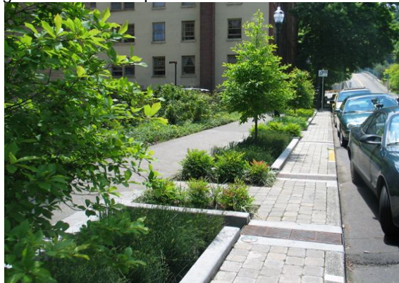
Figura 5 – Canteiro pluvial na cidade de Portland - EUA
