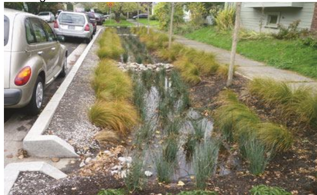
Figura 7 – Biovaleta na cidade de Portland - EUA
