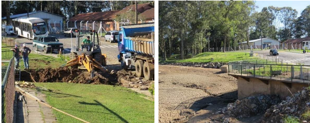
Figura 23 – Obra de infraestrutura e rompimento do lago norte
