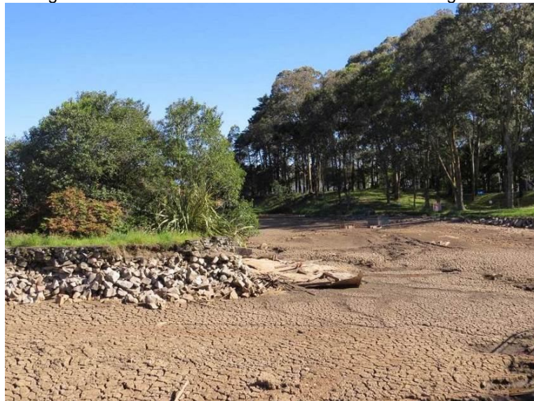
Figura 26 – Entulho e lodo acumulado no fundo do lago norte
