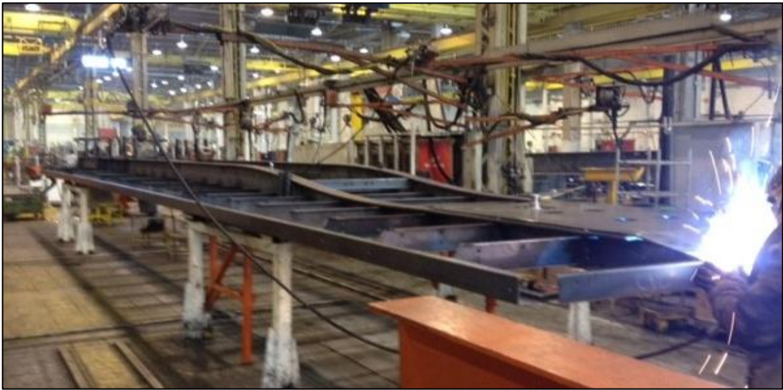
Figura 15 - Posto de solda antes do giro
