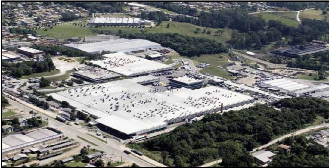
Figura 1 - Vista aérea da unidade Ana Rech
