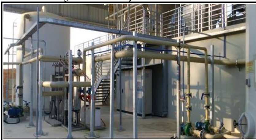
Figura 10 - Instalação sistema de ETE
