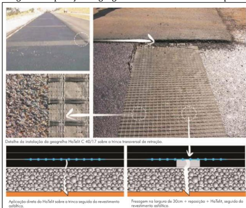
Figura 7 - Aplicação de geogrelha no Anel Viário de Campinas
