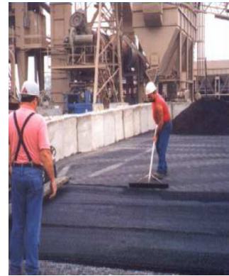
c) Pavimentação asfáltica [3]
