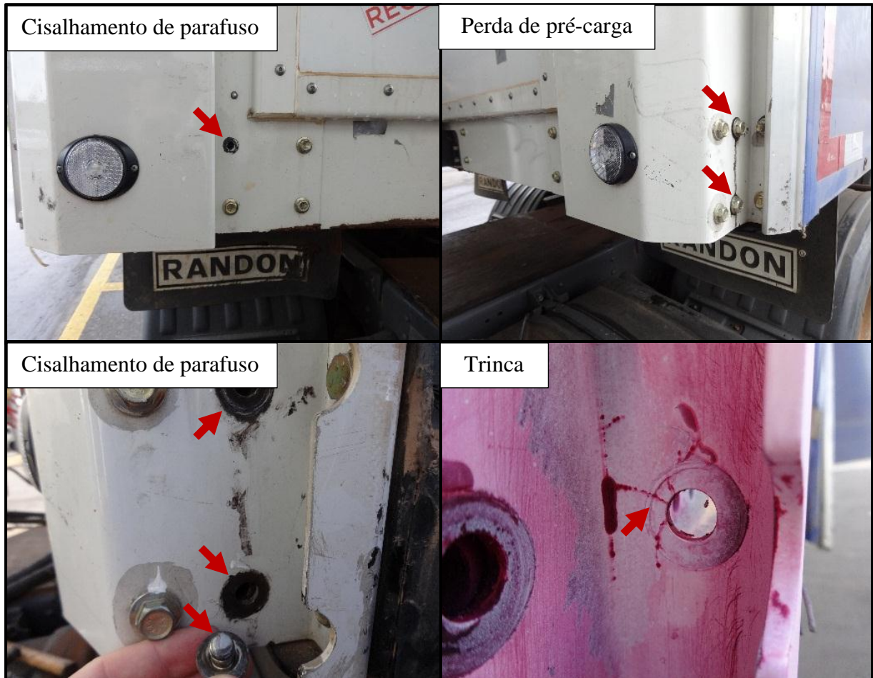
Figura 10 – Evidências de concentração de tensões na junta aparafusada frontal do sider .
