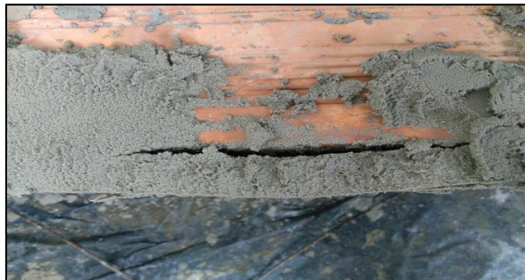
Figura 27 - Aplicação da argamassa estabilizada as 72 horas de estabilização
