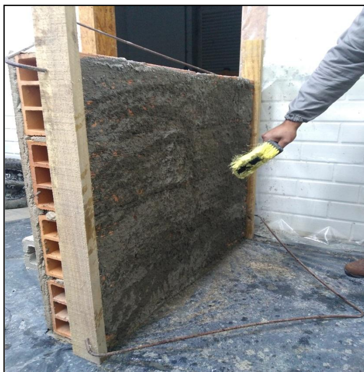
Figura 15 - Mestras para execução do revestimento
