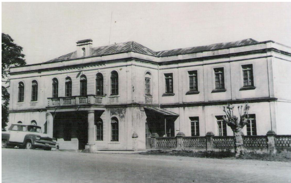
Figura 11 - Prédio da antiga Intendência Municipal utilizado pelo Colégio São José
