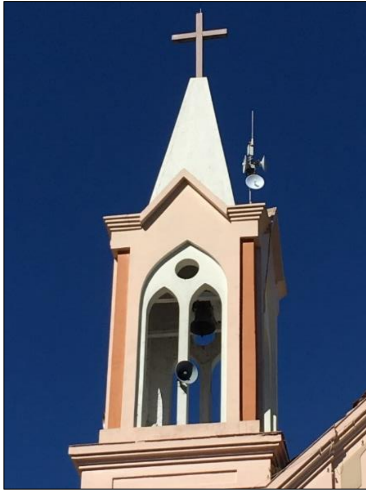
Figura 25 – Torre da Igreja Matriz em que está localizado o sino
