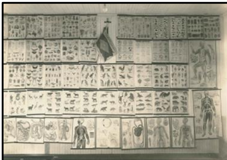
Figura 47 - Sala com materiais de Ciências
