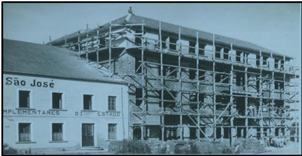
Figura 14 - Construção do edifício com três pavimentos, em 1942
