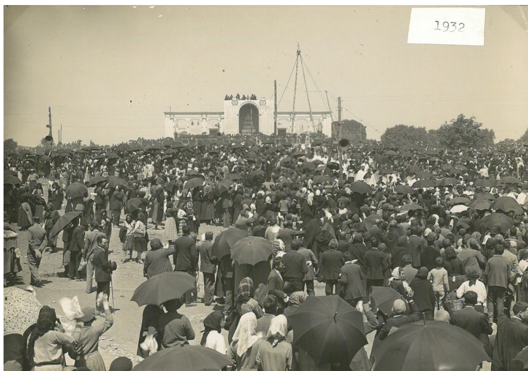
Figura 68 – Construção da Basílica Nossa Senhora do Rosário de Fátima. 1932
