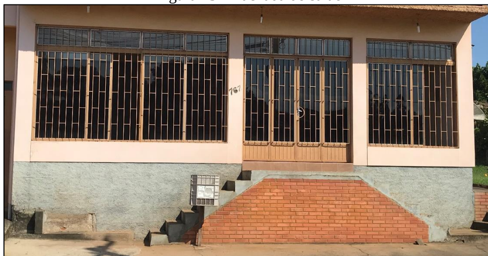
Figura 23 – Fachada do salão
