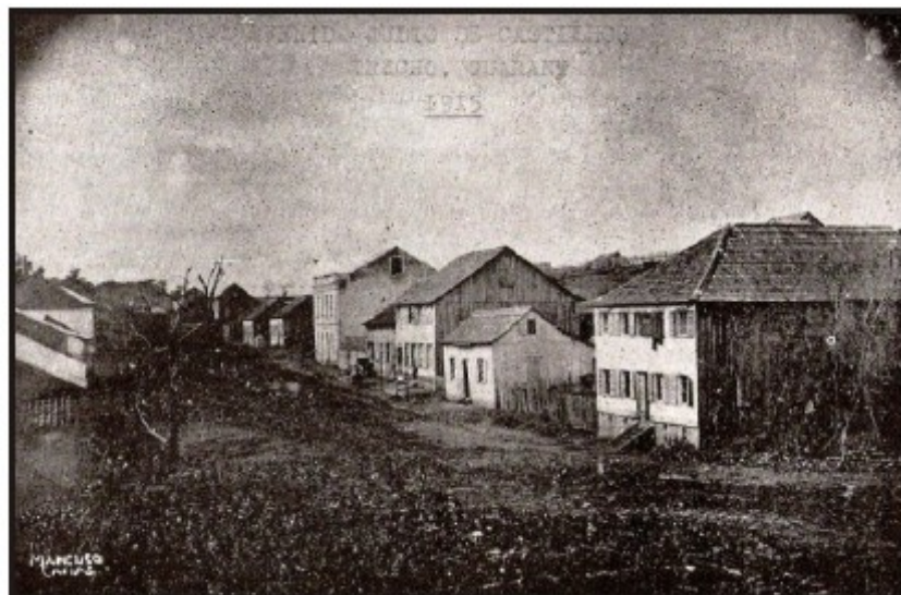
Figura 4: Trecho antigo da Avenida Júlio de Castilhos, no qual divisamos o velho prédio Balen ainda existente, 1ª casa de material em Caxias do Sul, que albergou as irmãs no 1º ano que funcionou a Escola São José Fonte: Acervo da Casa Provincial, 50 anos da Congregação São José, 1951, p.21.
