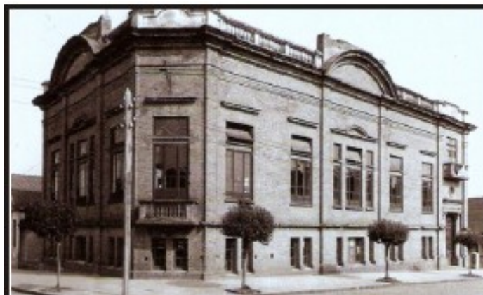
Figura 37: Vista do prédio na época da aquisição em 1945 Fonte: Memorial do Círculo Operário Caxiense.
