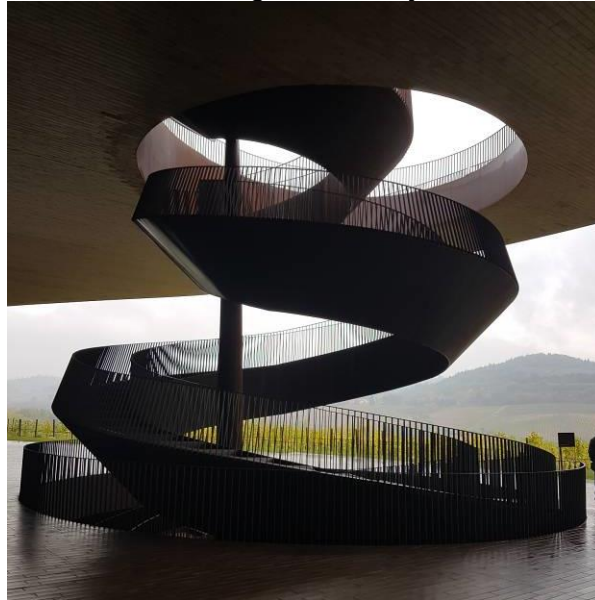
Figura 13 - Escada em formato de saca rolas para acesso a diferentes pavimentos, Cantina Antinori, Bargino, Florença, Itália.
