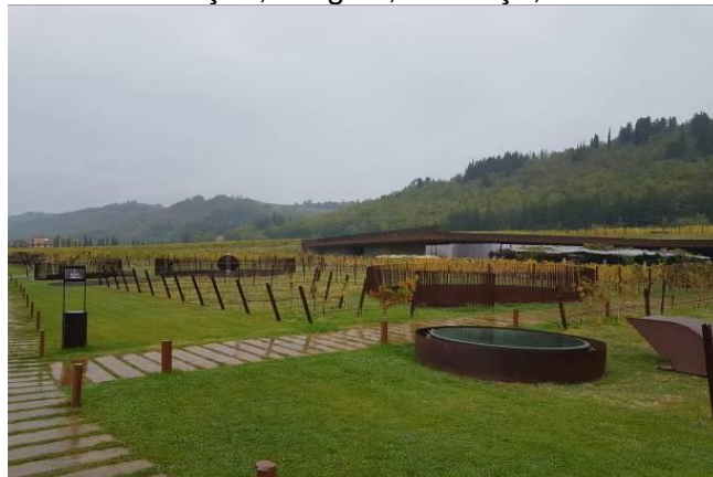
Figura 14 - Vinhedos na superfície da Cantina Antinori, destacando as claraboias de iluminação, Bargino, Florença, Itália.
