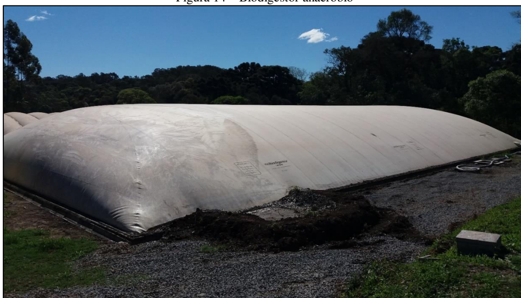
Figura 14 – Biodigestor anaeróbio
