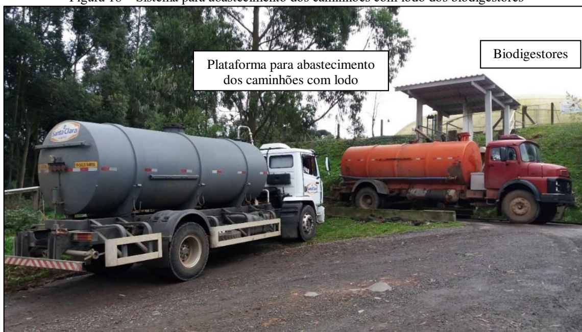
Figura 18 – Sistema para abastecimento dos caminhões com lodo dos biodigestores
