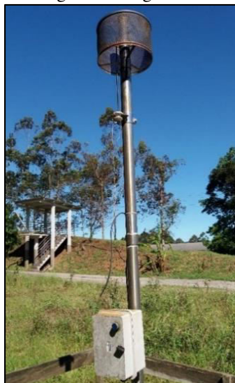
Figura 32 – Queimador de gases com ignitor automático tipo open flare
