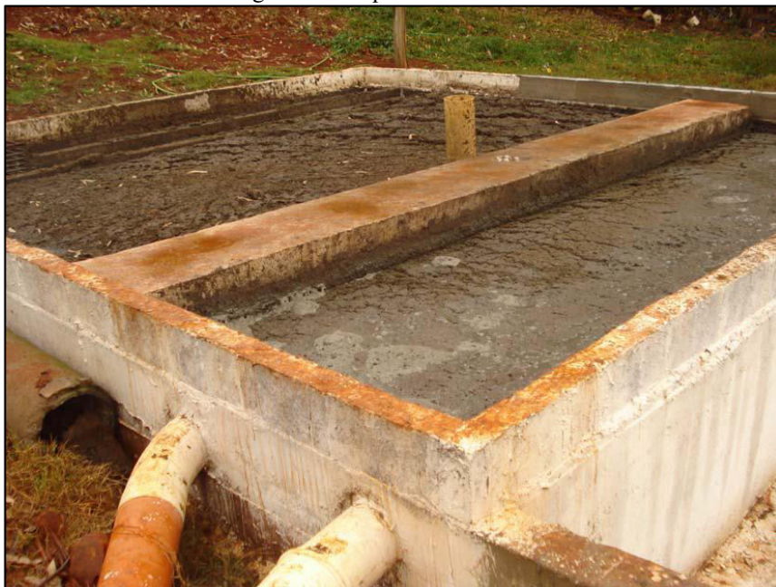
Figura 19 – Equalizador de vazão
