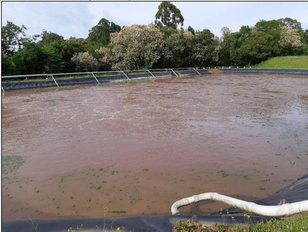
Figura 25 – Lagoa de estabilização de efluentes
