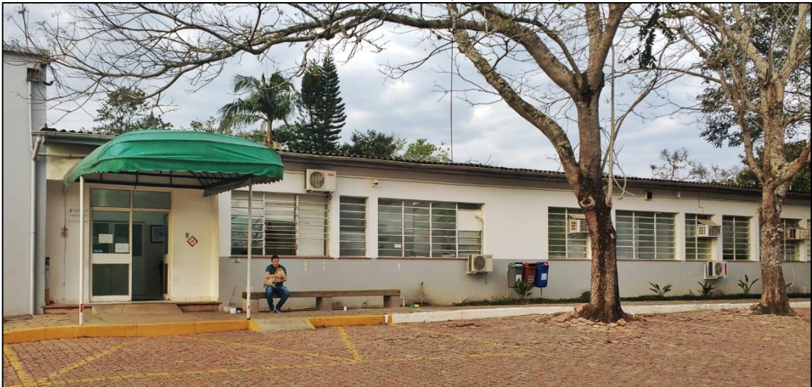
Figura 1 - Apresentação da fachada do Hospital Veterinário da Universidade Federal de Santa Maria/RS (HV-UFSM)
