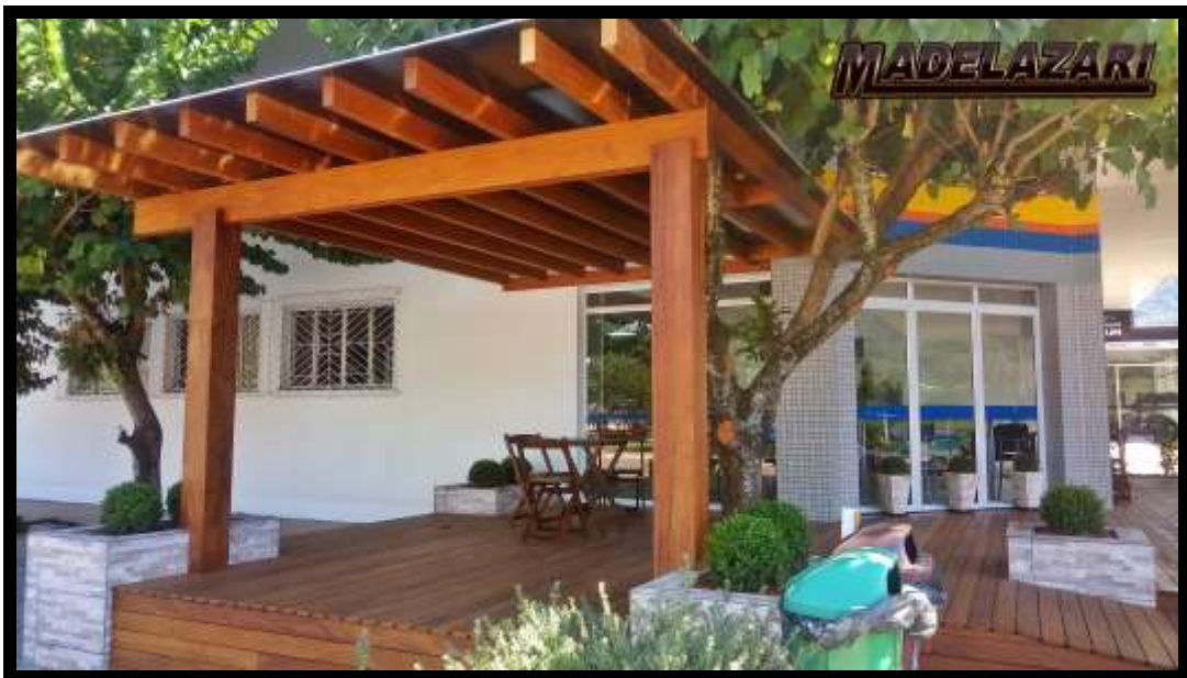
Figura 14 - Pergolado com barrotes e colunas em garapeira e deck de cumaru
