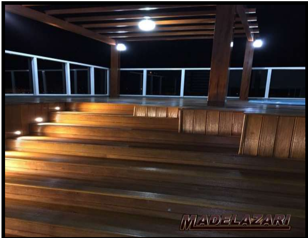
Figura 12 - Deck de Cumaru usado para escada e revestimento
