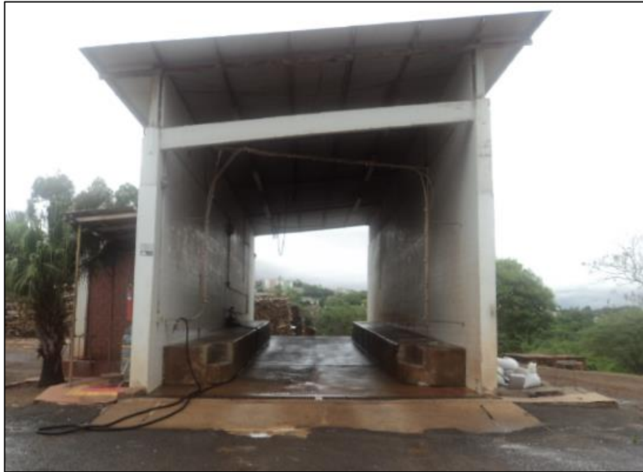
Figura 2: exemplo para banho de aspersão em caminhões
