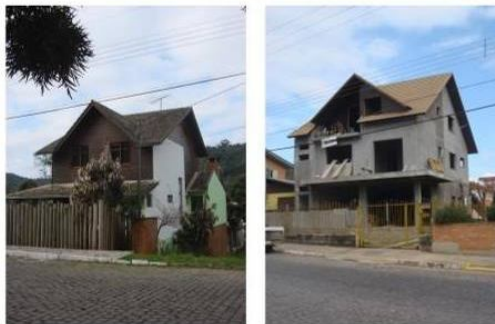
Figura 8: Edificações novas nas áreas protegidas e não protegidas pelo IPHAN em Antônio Prado. Mapa e fotos: acervo Escritório Técnico II – Antônio Prado / IPHAN-RS
