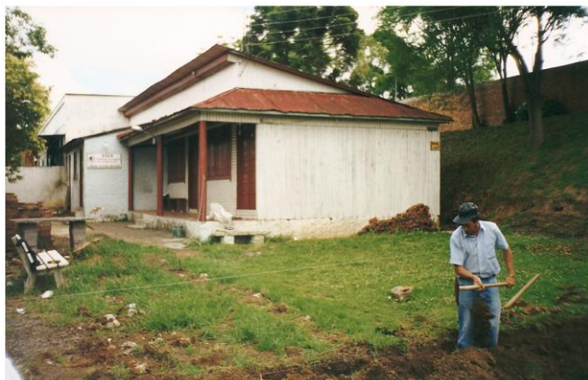
Construção da Sede Social
