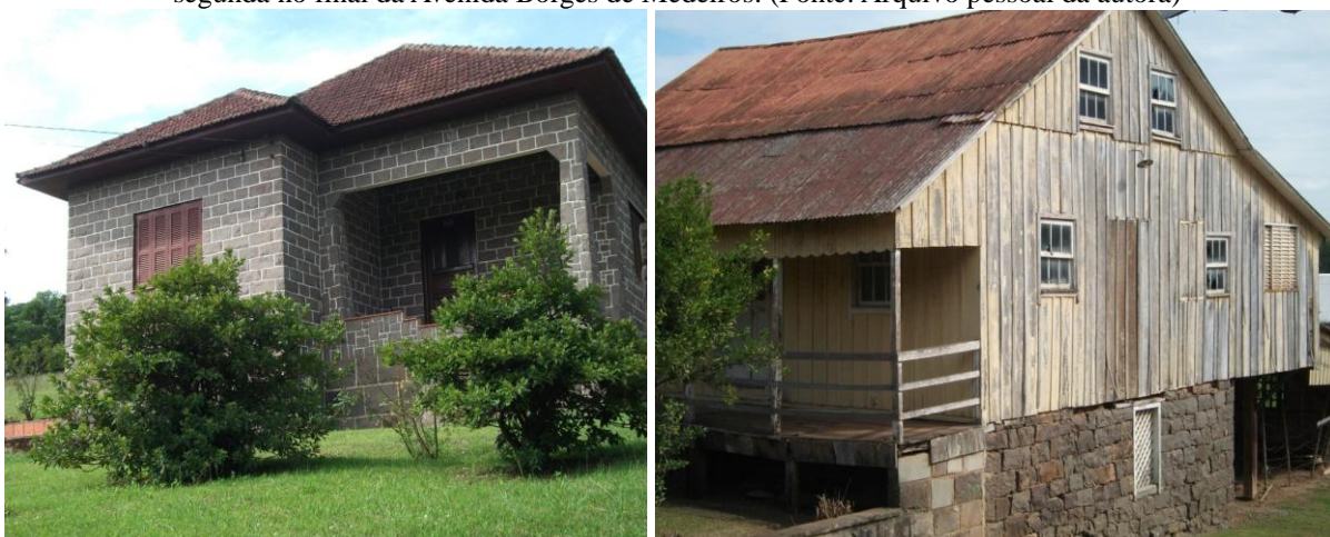
Fotos do Bairro Várzea Grande em Gramado: casa de pedra, típica italiana, de propriedade da família Till e chalé de madeira com telhado de zinco, repleta de janelas, de propriedade da família Tissot, ambas originalmente preservadas, porém fechadas, sem moradores. Localizam-se na área urbana da cidade de Gramado-RS. (Fonte: Arquivo pessoal da autora)
