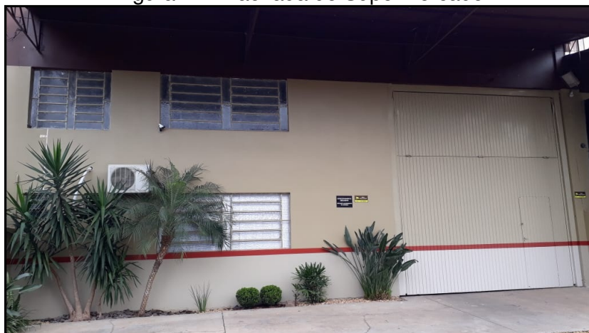
Figura 22 - Fachada do Supermercado
