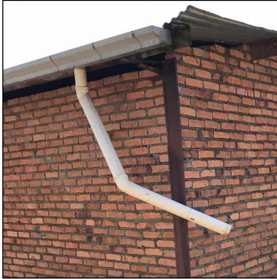
Figura 10 – Conexão da calha ao condutor vertical
