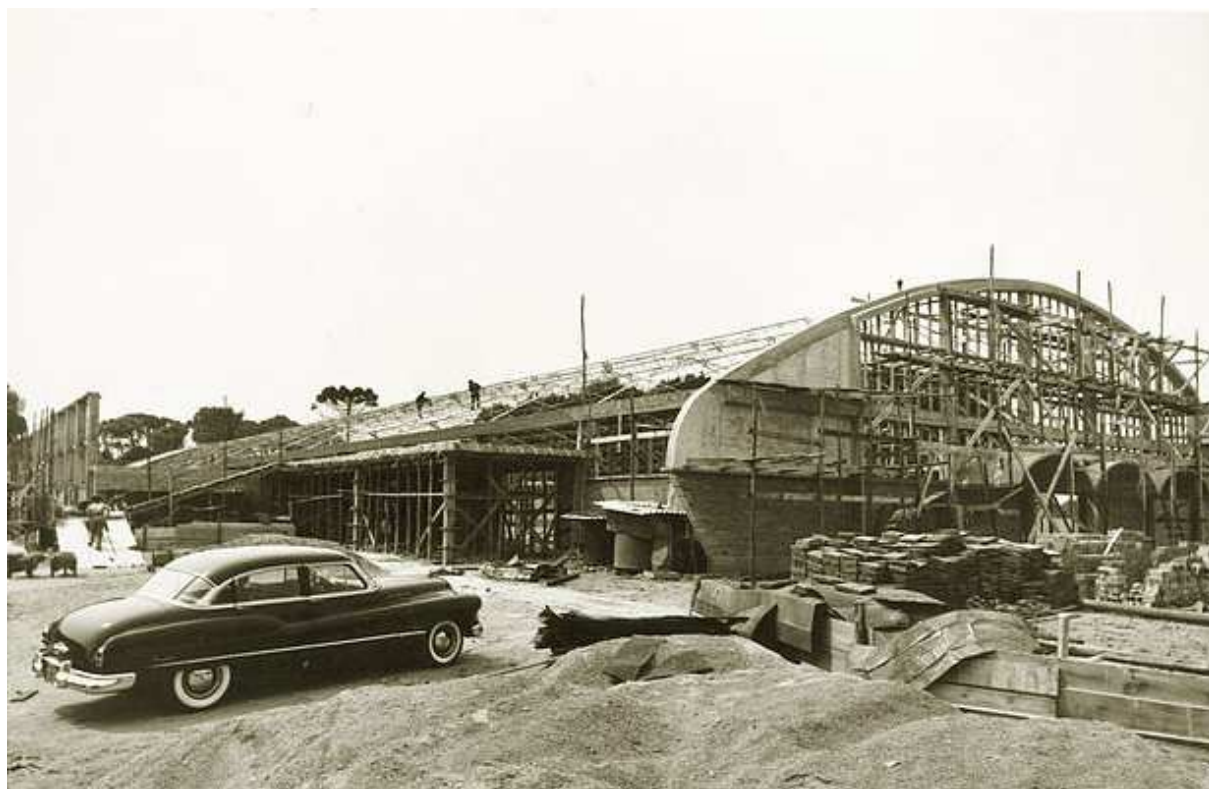
Figura 18 - Construção da estrutura do telhado da nova fábrica de talheres da Metalúrgica Gazola em outubro de 1962.
