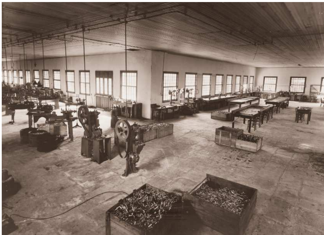
Figura 24 - Foto da sala principal em "L" após a reconstrução do prédio.
