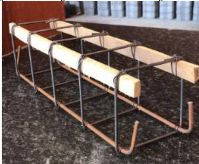
Figura 27 - Montagem das armaduras das vigas de bambu
